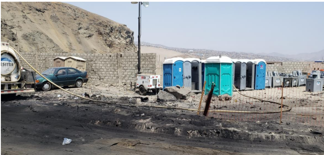
Fotografía 8. Succión de baños químicos sin delimitación en área de tránsito, sin vigilancia
