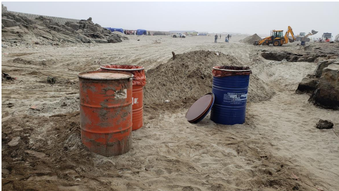
Fotografía 10. Almacenamiento primario sin impermeabilización del suelo y sin diferenciación de residuos
