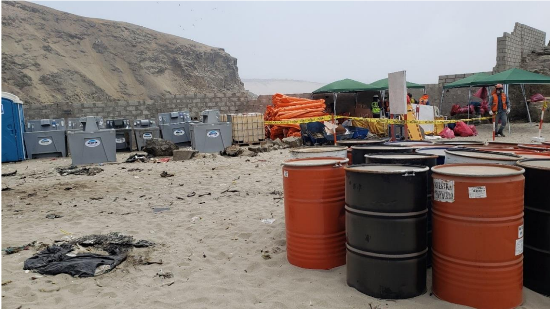
Fotografía 13. Coexistencia de zona limpia (lavamanos, servicios higiénicos) y zona sucia (almacenamiento de residuos), ausencia de vías peatonales de circulación (se expone el suelo a los contaminantes por la circulación de operadores)
