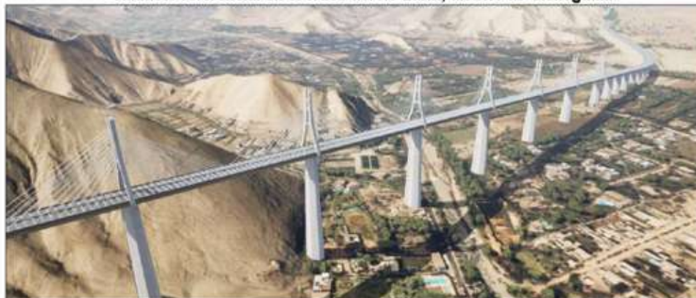
Imagen N° 2 Viaducto referencial en el cruce del río Lurín, distrito de Cieneguilla
